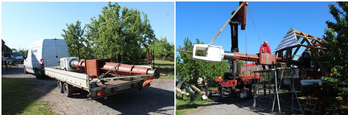
Soeben wurde die von einem Spezialunternehmen neugegossene Flügelwelle bei der Mühle angeliefert. Mit einem Kran wurde sie in die Mühlenkappe eingesetzt und ausgerichtet. Jetzt sind die Zimmerleute gefragt, die Balkenkonstruktion der Mühlenkappe zu reparieren. Anschließend bringt der Dachdecker die vom Denkmalamt des Landkreises festgelegte Dacheindeckung an. In der zweiten Junihälfte sollen sich die Flügel der Mühle wieder im Wind drehen.
